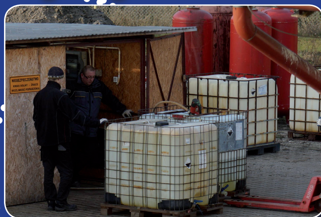
Prace przy kwasowaniu / Acidizing works
