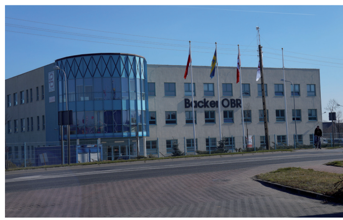
Zakład Backer OBR - jeden z największych odbiorców ciepła The Backer OBR company - one of the biggest heat consumers
