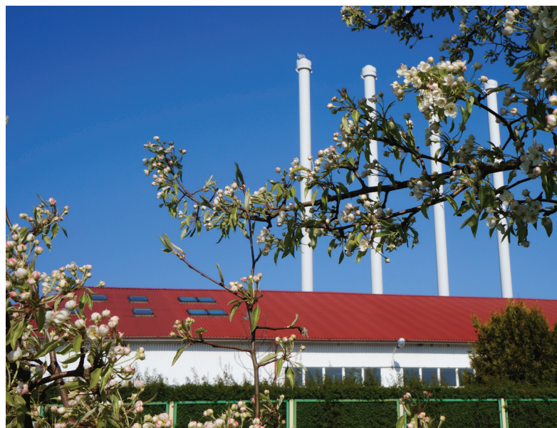
Widok na ciepłownię
