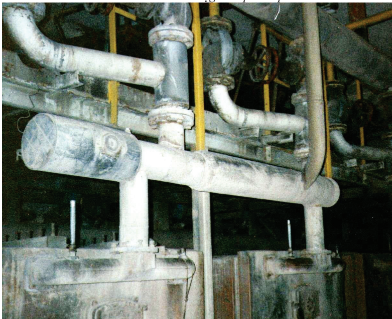
Stara kotłownia węglowa przed powstaniem Geotermii
